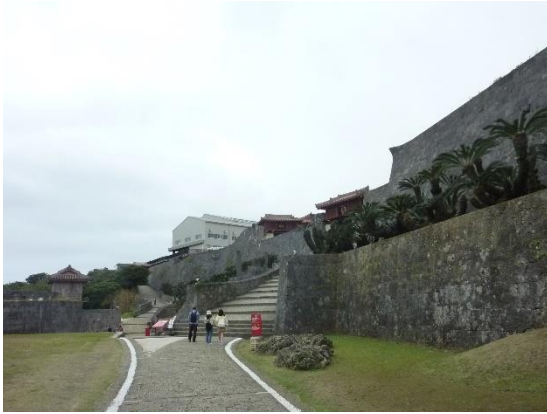
奥の建物の中で再建中
